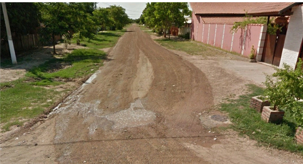
Foto 06 – Rua Afonso Pena Coordenadas geográficas: 21°42'13"S / 57°53'31"O
